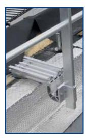
Der Fuß ZEDFIX II (60, 120, 160) kann unter der Mauerabdeckung montiert werden. ZEDFIX II ist geeignet für wärmegedämmte Attiken bis zu einer Dicke von 160mm.
